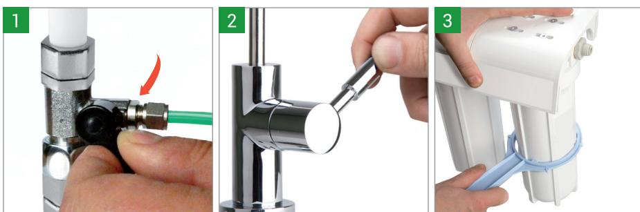
Preporučuje se da se Oring prsten pre ponovnog instaliranja premaže silikonskom mašču ili vazelinom, postavite filter bocu i zategnite je. Proverite da li postoje negde curenja, ukoliko ne otvorite dotok vode do filtera (slika 6.)
